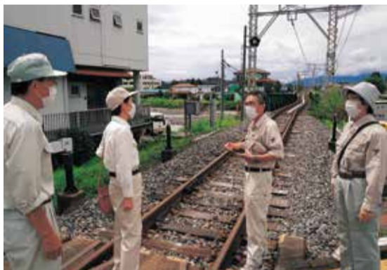
災害で折れ曲がった線路（辰野町・8月19日）
