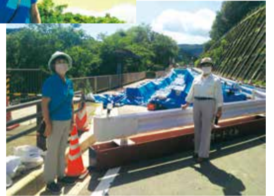
信州新町水篠橋付近現地調査(9月10日)
