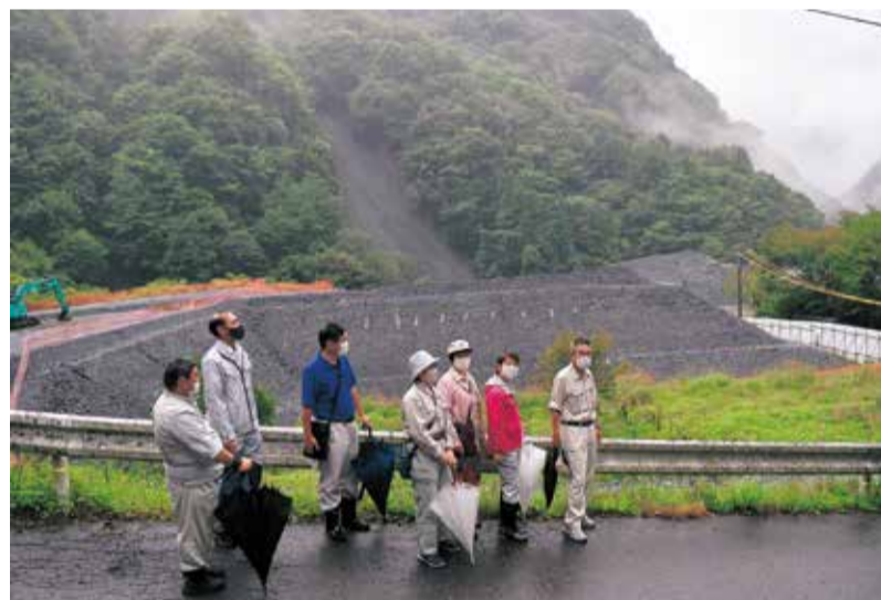
大鹿村釜沢の発生土仮置場を視察（9月2日）
