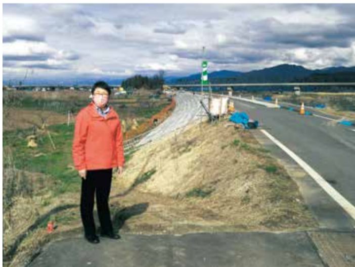
千曲川で被覆型堤防工事が実現
