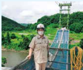
豊田中野線笠倉壁田橋建設 現場現地調査(7月4日)
