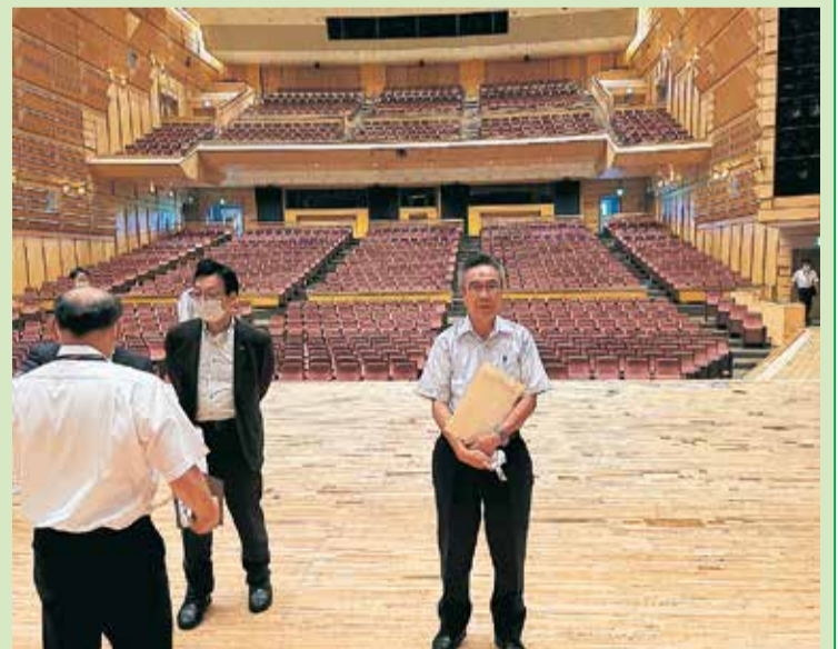
天井の耐震化、大規模工事が行われた伊那文化会館
