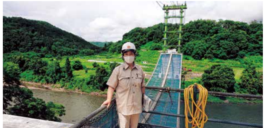
豊田中野線笠倉壁田橋の建設現場（7月4日）
