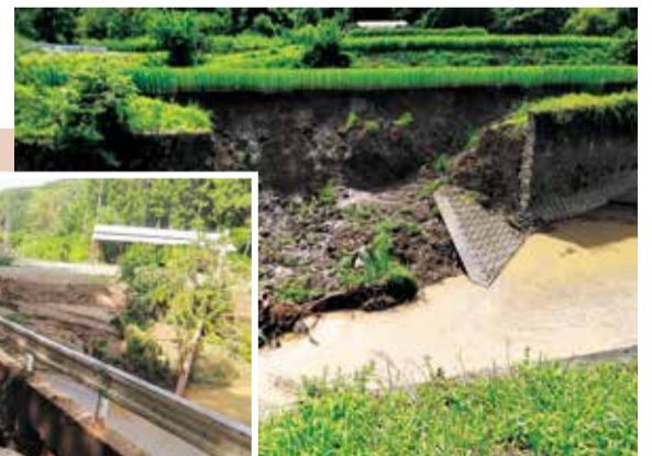
小川村豪雨で道路陥没・護岸壁倒壊現場視察
