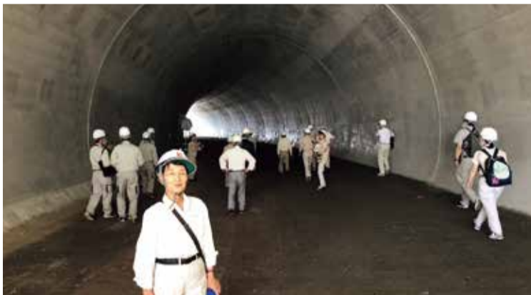
平山トンネル調査(7月12日)
