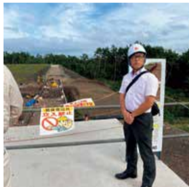
浅間山直轄火山砂防事業で建設中の砂防堰堤を視察(8月30日)
