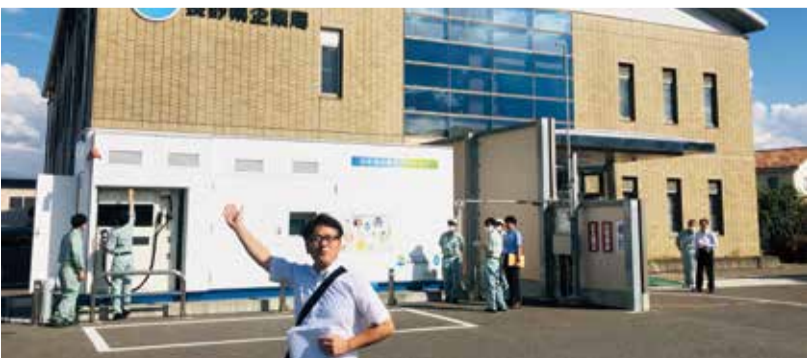
長野県企業局川中島水道管 理事務所へ (決算特別委員会の現地調査 9月5日)
