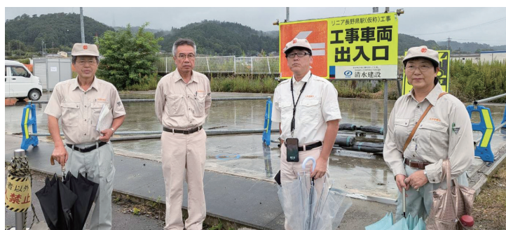
飯田市のリニア中央新幹線工事現場（9月12日）
